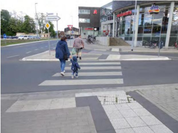
Abbildung 57: Bodenindikatoren, gesicherte und getrennte Querung als Zebrastreifen/FGÜ am Gebrüder Kerkmann-Platz
